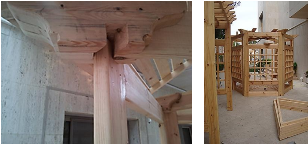
(شكل 28) يوضح طريقة تجميع وحدات المظلات الخشبية "الأجناب مع القاعدة وعوارض السقف"
