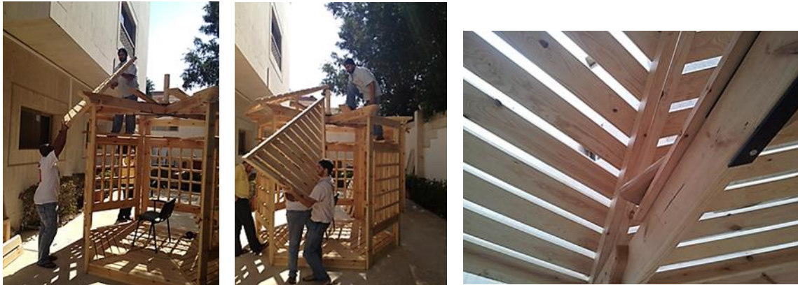
(شكل 31) رفع وحدات السقف لوضعها مكانها أعلى العوارض وكما هو موضح الفراغات بين ألواح الخشب لسهولة التهوية ومرور الهواء وضوء الشمس دون التأثير على الجالسين بداخلها
