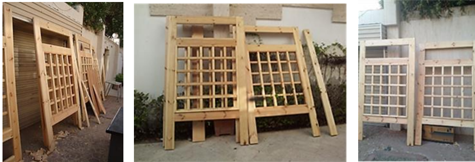
(شكل 24) يوضح أجناب المظلات بعد تجميعها
