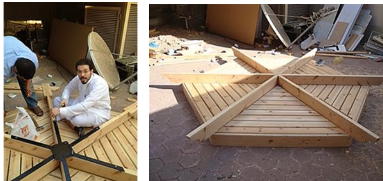
(شكل 25) يوضح تجهيز وتجميع وحدة السقف للمظلة السداسية وقد تم إبتكار وحدة تجميع معدنية لتكون مثبتة من الجهتين "أعلى وأسفل عوارض السقف
